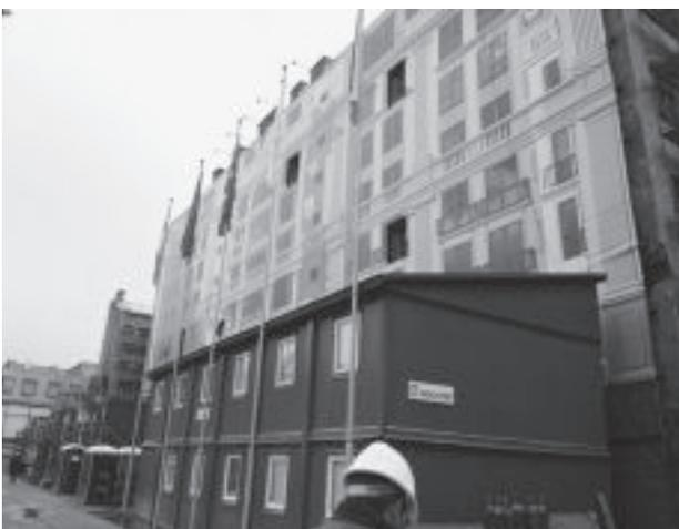
写真-9a. まるでそこに建物があるような雰囲気の中での建物の工事
