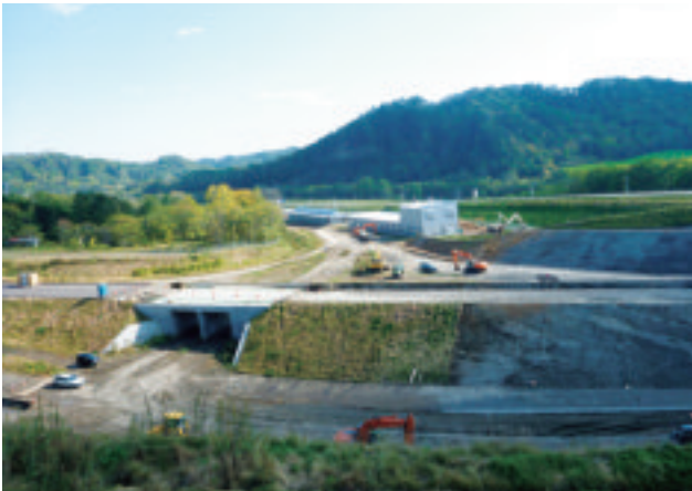
【建設中の白糠 IC】
