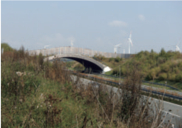
ヴィルムスハーゲンにある動物移動用の木製の オーバーブリッジ(景観に溶け込み違和感がない)
