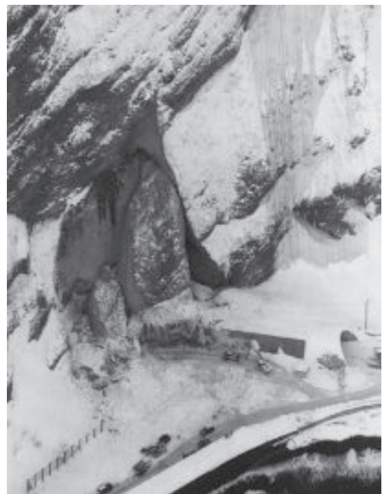
写真-5 豊浜トンネル崩落事故 資料提供：北海道開発局
