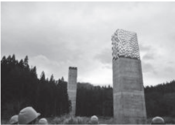
写真 3 鋼管コンクリート橋脚
