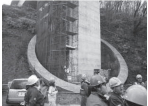
写真 2 橋脚部の竹割り型構造物
