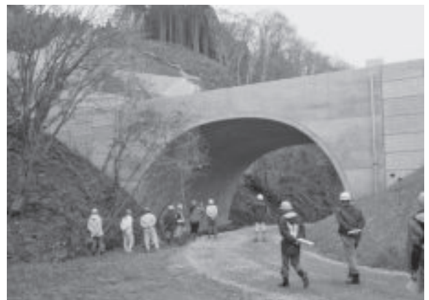
写真 4 アーチカルバート
