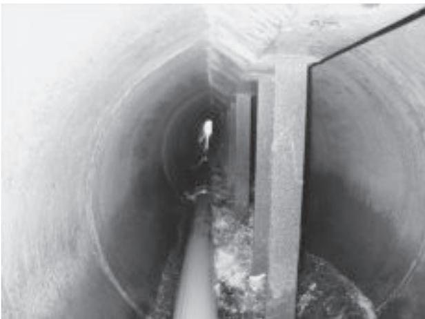
写真 管渠内鋼製レール設置状況
