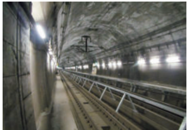
青函トンネル本坑
