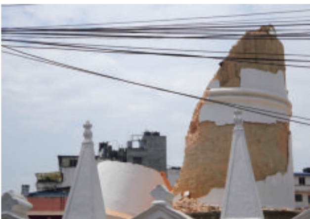
口絵-29 倒壊したビムセン・タワー
