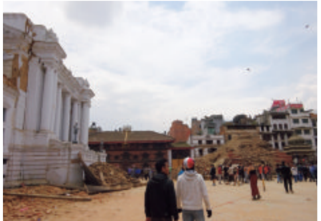
口絵-8 崩れたバルコニーと屋根の傾いたクマリの館、 崩壊したナラヤン寺院とシヴァ寺院
