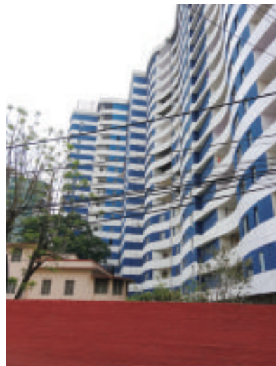
口絵-28 傾いた高層マンション
