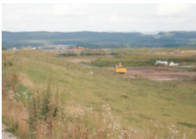
掘削工事中の根志越遊水地
