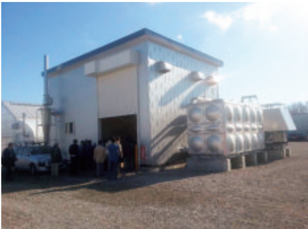
木質バイオマスボイラー全景、この中にボイラーと 木質チップが格納
