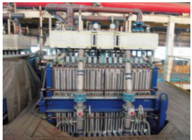
本年9月に更新される前の旧電解槽(F1、単極式) これを新しいものに更新した
