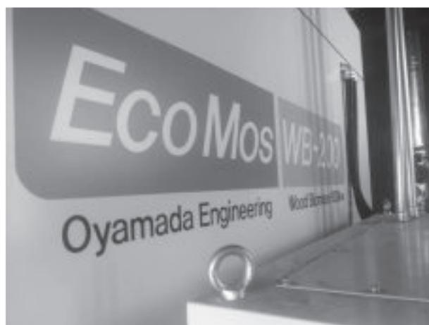
写真-4. 木質バイオマスボイラー(200kW クラス) この規模のボイラー 1 台で 2ha もの温室の温水を賄っている。エネルギー効率の高さは驚きだ
