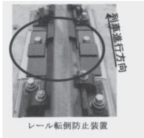
図-4 レール転倒防止装置
