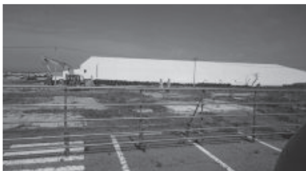
写真-19 JR 常磐線富岡駅跡地(ホーム間の線路内に重機が入っている)と震災がれき処理焼却施設(背後の白い建物)
