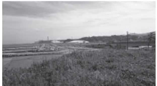
写真-27 震災がれき処理焼却施設(白い建物)と福島第二原子力発電所(左側奥の煙突と建物)
