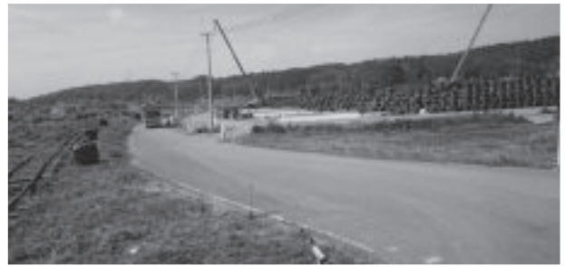
写真-18 震災がれき処理焼却施設周辺の除染袋の山
