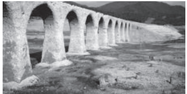
写真 3 国道から離れているタウシュベツ川橋梁
