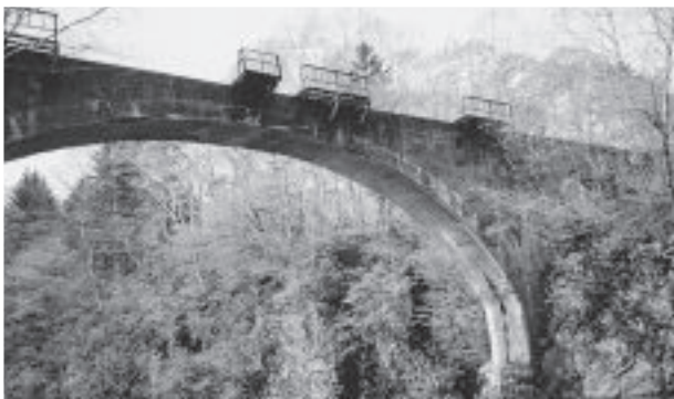
写真 1 自然と融和している第三音更川橋梁
