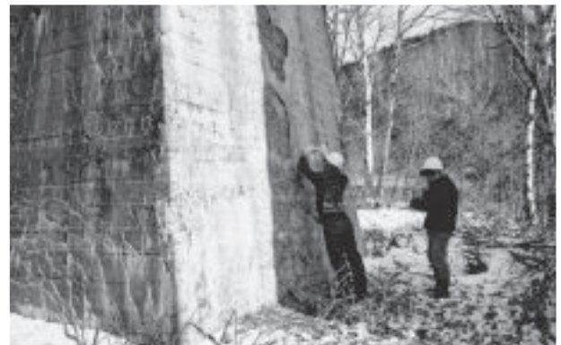
写真 2 第三音更川橋梁の調査風景
