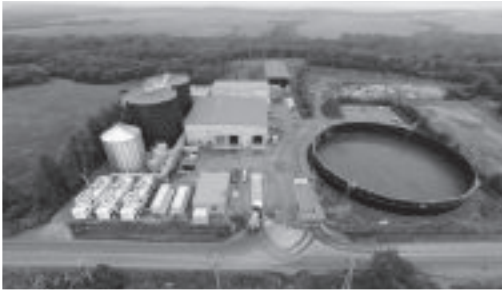
写真-2 バイオガスプラント全景
