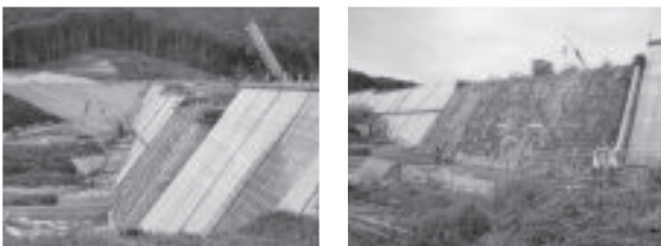
写真 ダム建設現場(左)と常用洪水吐き(右)
