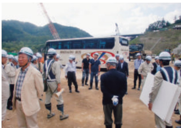
堤体建設現場
