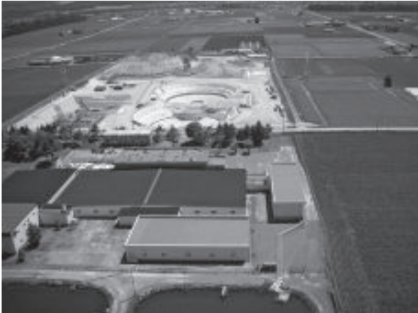
写真：工事中の浄水場全景
