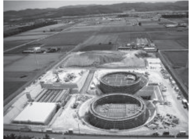
写真：工事の様子
