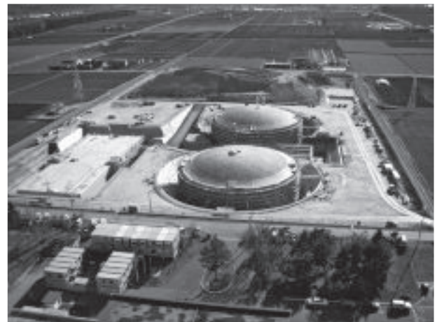
写真：コンクリート打設完了
