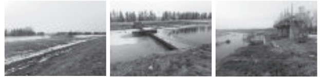
第二売買川 堰 売買川 堰 売買川 水門
