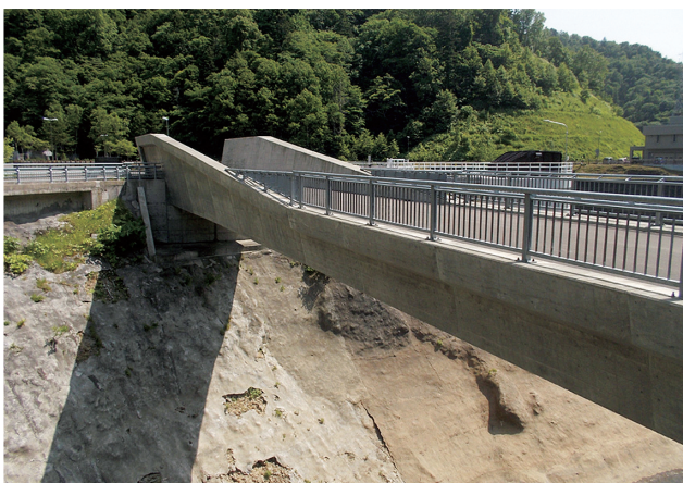
ダム管理や観光等に利用されているカムイ・ニセイ橋 堤体に荷重をかけない片持ち構造のPC橋でした
