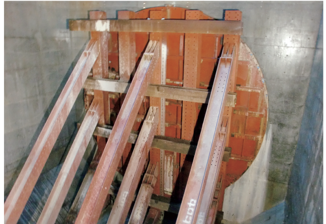
呑口側シールド到達予定箇所
