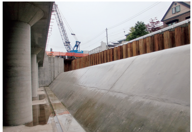
呑口部内側からみた越流部
