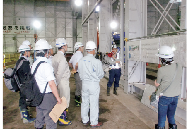
発進立坑防音ハウス内でのシールド工事概要説明
