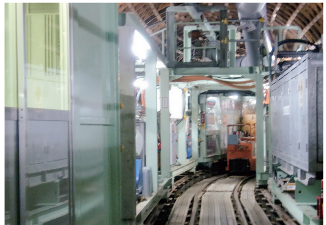
シールドトンネル坑内
