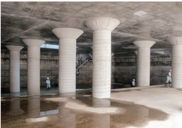
呑口部沈砂池内部
