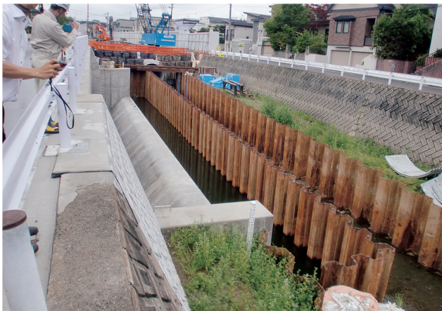
河川側から見た越流部
