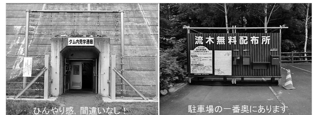
写真-1 定山溪ダム 見学坑入口と流木配布所
