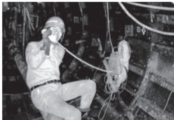
シールド工事現場にて
