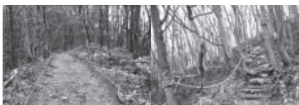
写真-3 整備された登山道の状況
