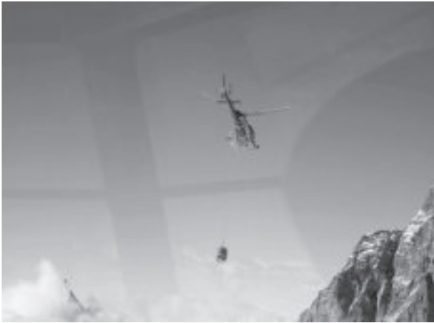
写真-4 コンクリート空輸状況
