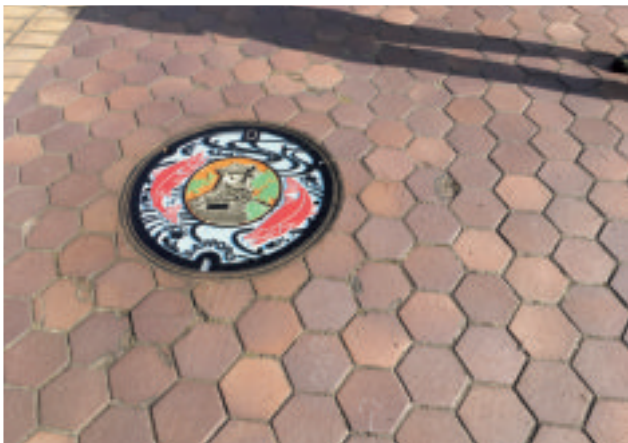
色付き下水道マンホール
