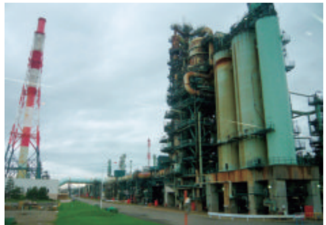
出光興産株式会社北海道製油所の製造施設
