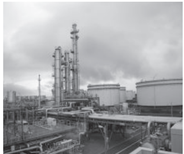
写真-1 CCS実証試験センターの全景 (管理棟屋上から地中圧入棟方向を臨む)
