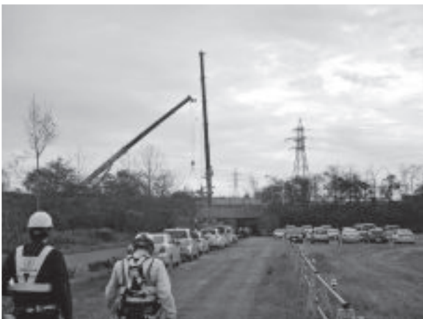
写真-3 工事状況
