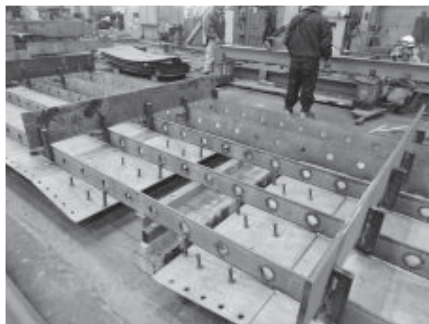
図-6 合成床版 製作状況
