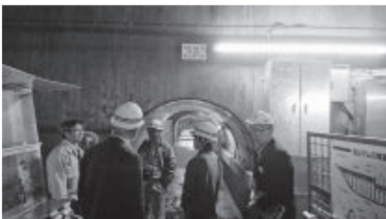
写真-5 中空重力式ダム内部
