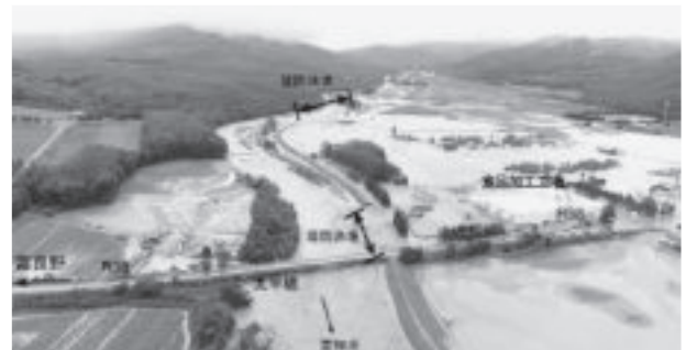
写真-6 被災時状況
