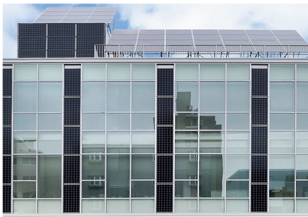
本社ビルの屋上や壁面に張り詰められた太陽光パネル
