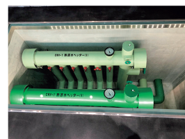
本社ビル地下に設置されている地中熱ヒートポンプ
