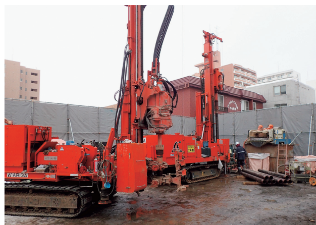
高性能掘削機械による削孔状況
