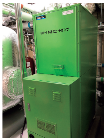
本社ビル地下に設置されている地中熱ヒートポンプ
