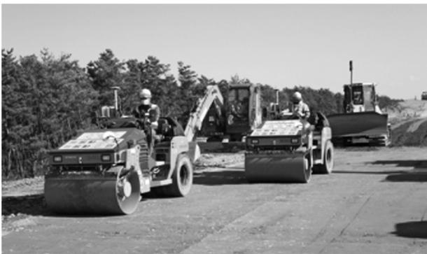
写真-5 CSG 締固め状況
