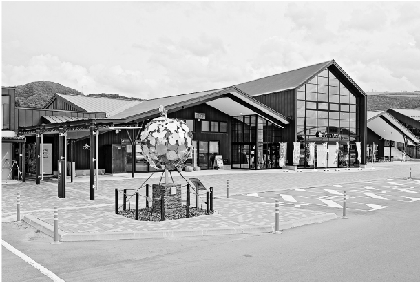
写真-1 なないろ・ななえ 外観
