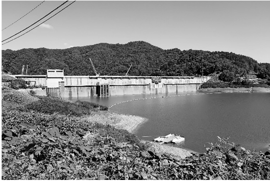
写真-2 新桂沢ダム工事現場②
