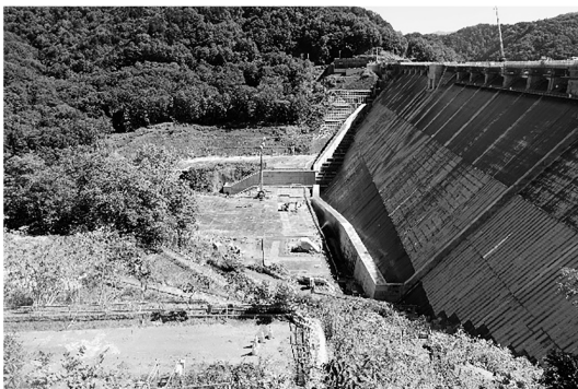
写真-1 新桂沢ダム工事現場①
