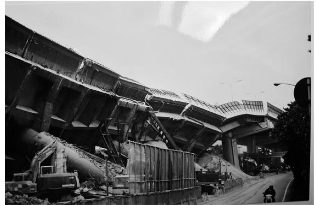
倒壊したピルツ形式の連続RCスラブ橋
