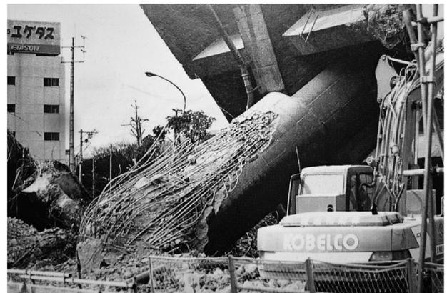
柱基部コンクリートがせん断圧縮破壊し倒壊した橋脚
