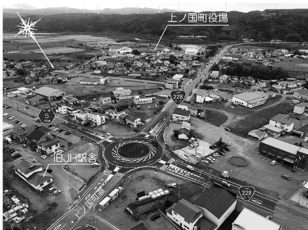
図-4 完成したラウンドアバウト
