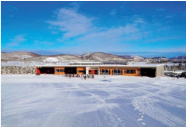
道の駅2階・ロジ部分
