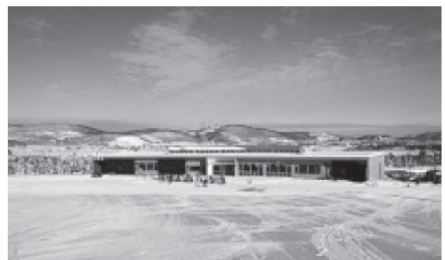
図-5 道の駅 2 階・ロッジ部分
