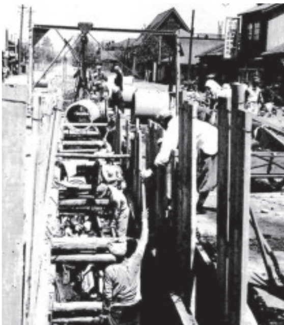
写真-1 1958年当時の工事状況(出典:札幌市公文書館)
