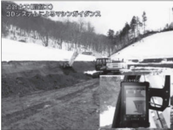
図-6 3D システムを用いたマシンガイダンス施工
