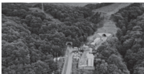
図-3 終点側坑口施工写真(江差側)
