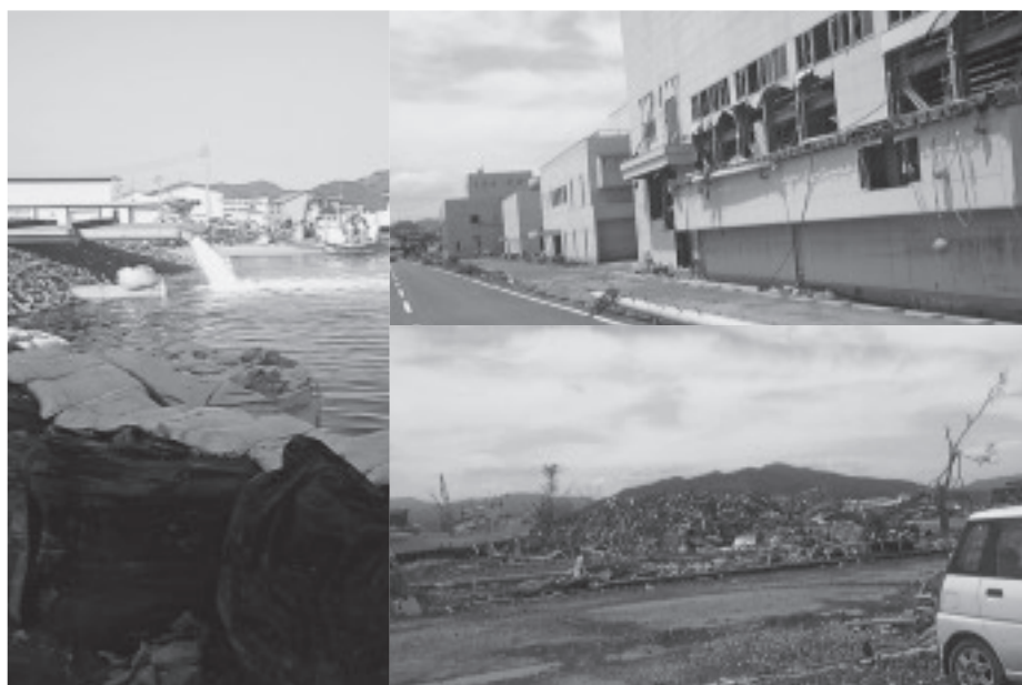
写真-9 被災下水処理施設と仮排水(東日本震災)
