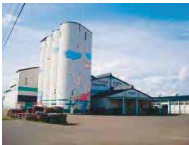
米穀雪零温貯蔵施設全景
